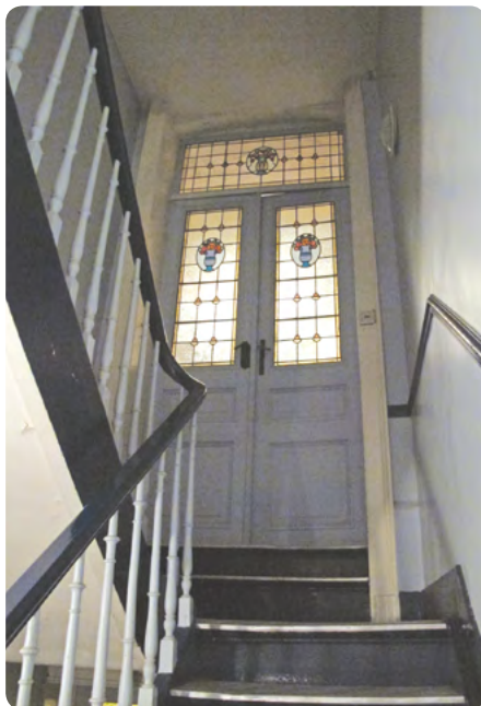
Voorbeeld van een deur met patrimoniaal karakter
