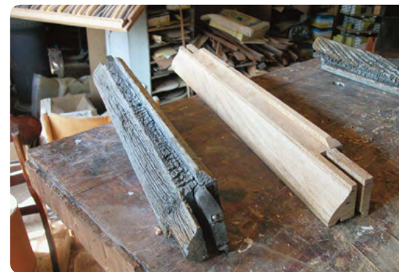
Exacte reproductie van een te vervangen onderdeel (waterlijst)
