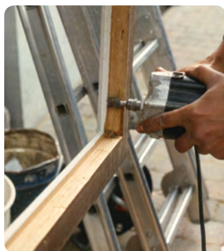
Plaatsing van dubbel glas met vergroting van de glassponning
