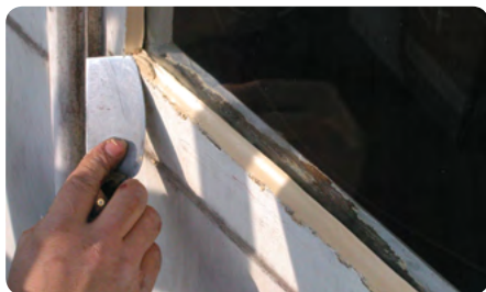
Vervanging van de beschadigde stopverf
