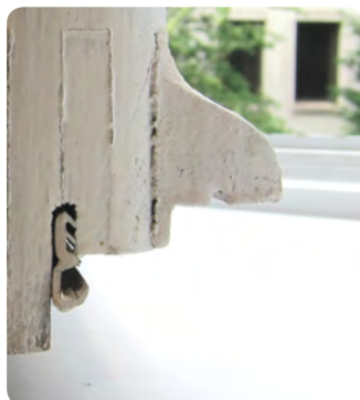
Soepele dichtingsstrip aangebracht door een schrijnwerker
