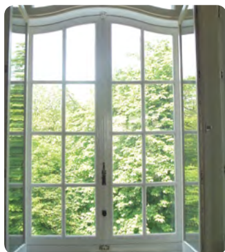
Plaatsing van een dubbel venster © Paul Mordan
