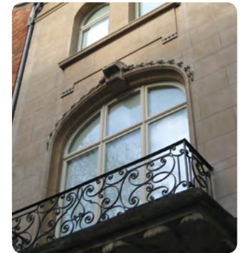
Hedendaags schrijnwerk waarbij de buitenkant het uitzicht van de oorspronkelijke ramen reproduceert. ©Frederic Hossey-AAC
