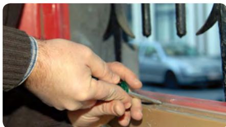
Vrijmaken van de afvoergaten aan de onderkant van het raam
