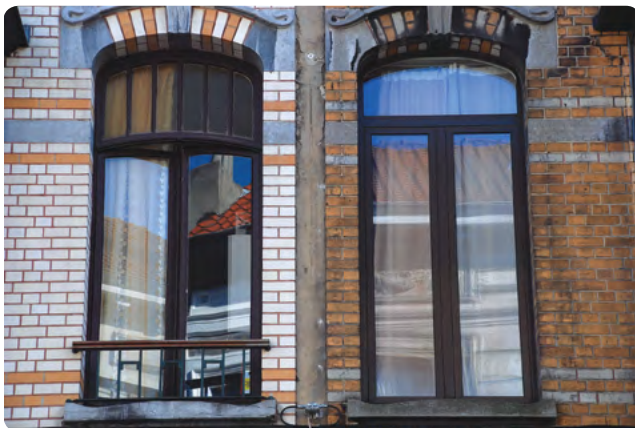
Links het oorspronkelijke venster. Rechts een niet-kwalitatieve vervanging van dit venster: te hoog geplaatste regel, te brede profielen, verlies van de verdelingsroeden en van het gekleurde glaswerk © Jacques Adnet
