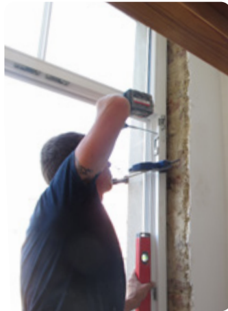
La pose d'un châssis exige une grande précision de la part du placeur.
