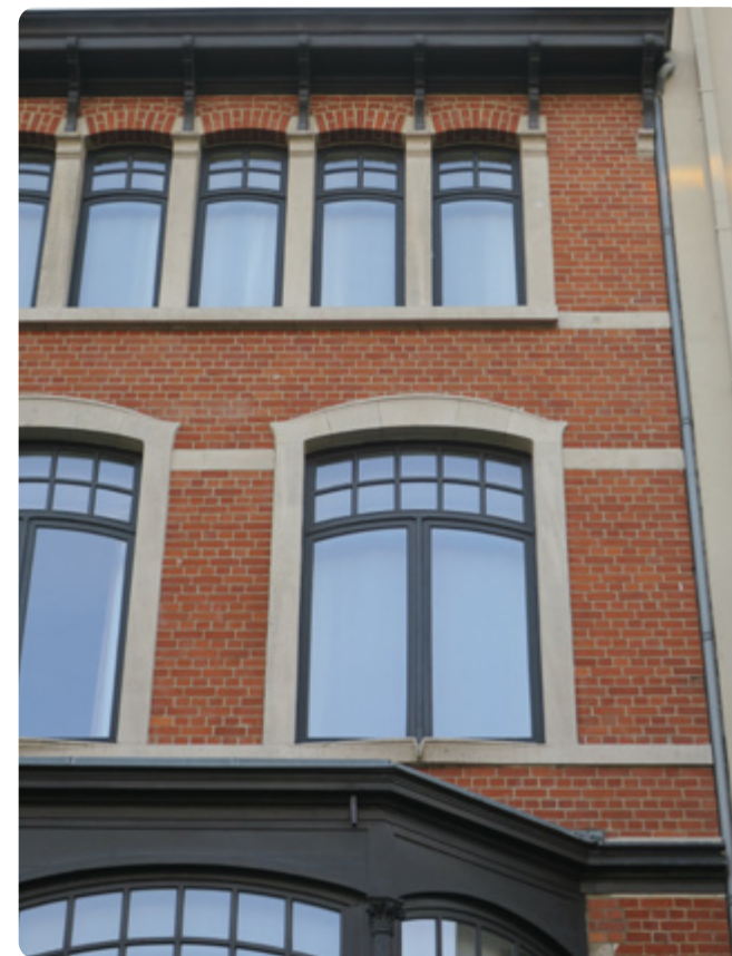
Châssis anciens équipés de double vitrage dans une maison de 1903 à Ixelles.
