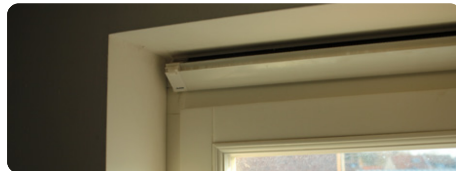
Aérateur placé au-dessus de la traverse supérieure du châssis.
