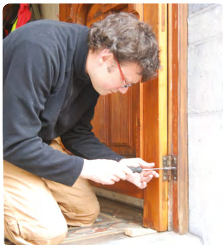
Repose de la porte après restauration
