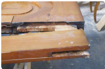
Démontage d'un montant à remplacer © Olivier Cabay
