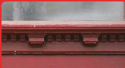
Imposte avec traverse moulurée de style néoclassique
