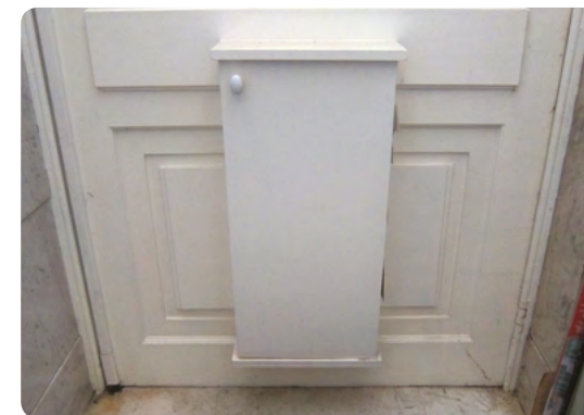
Boîte aux lettres étanche à l'air grâce à la pose d'un joint périphérique
