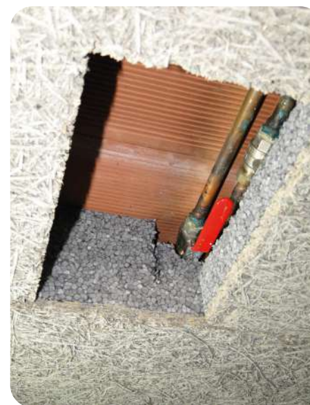
Er werd een verwijderbare plug in het isolatiepaneel gemaakt om toegang te krijgen tot de kraan van het waternetwerk in het isolatiepaneel © AGC
