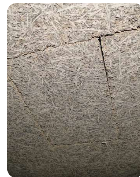
Er werd een verwijderbare plug in het isolatiepaneel gemaakt om toegang te krijgen tot de kraan van het waternetwerk in het isolatiepaneel © AGC
