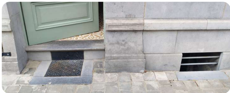
Kelderraam en opening voor een goede ventilatie
