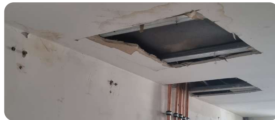
Bestaand verlaagd plafond tijdens de werkzaamheden
