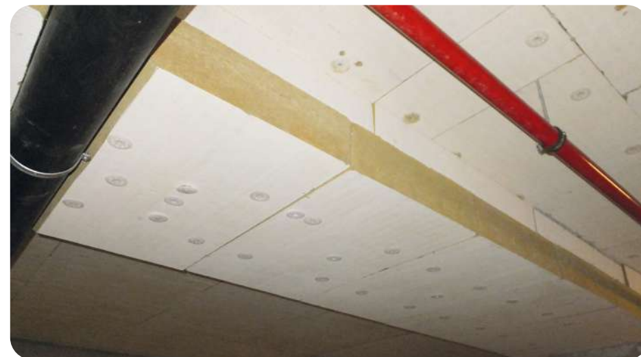
De isolatie volgt de vorm van de afvoerbuizen (afvalwater) die door de plaat lopen. De kabeldoorgangen zijn luchtdicht (soepele afdichtingen)
