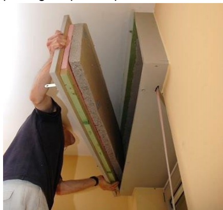
Figure 44 : Mise en œuvre
