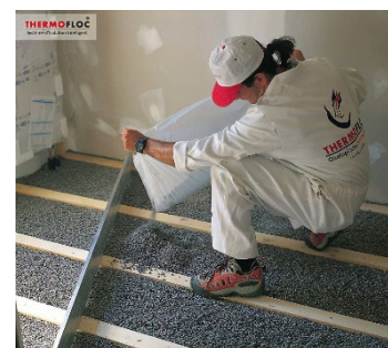
Figure 23 : Mise en œuvre (© Thermofloc)
