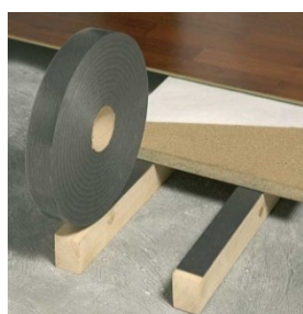
Figuur 20: Dempende stroken en blokken op/onder de balken
