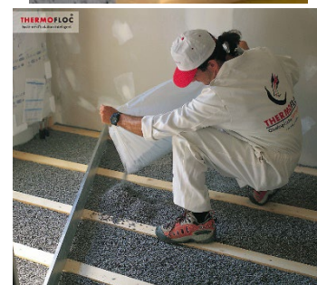
Figuur 17: Aanbrengen (© Thermofloc)
