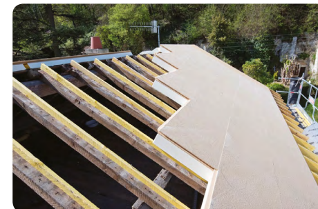
Pose de panneaux sandwich avec pare-vapeur, isolant et sous-toiture intégrés © Unilin Insulation
