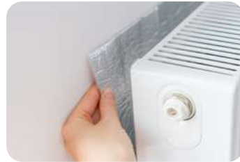
Installation d'un panneau réflecteur
