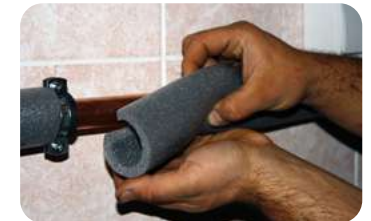
Placement d'une gaine en mousse
