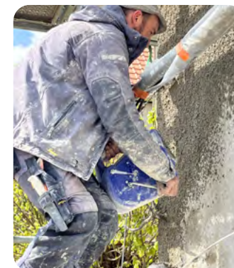
Application d'un enduit à la tyrolienne
