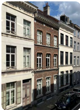
Façade privée de son enduit dans une enfilade néoclassique
