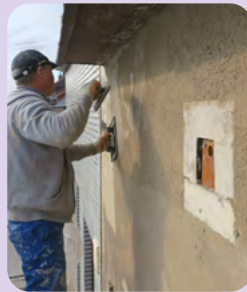
Lissage de la couche de finition
