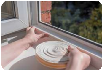
Aanbrengen van een rubberen band
