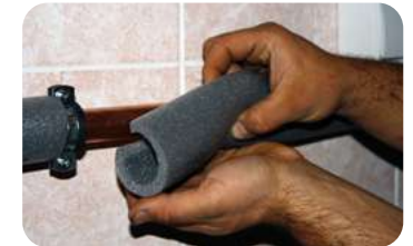
Aanbrengen van een schuimrubberen huls
