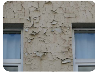
Loslaten als gevolg van een verkeerde verfkeuze
