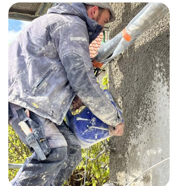
Aanbrengen van pleister met de spatmolen
