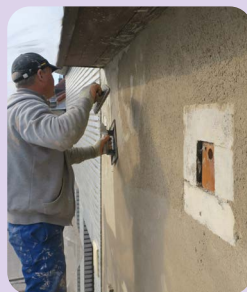
Gladstrijken van de afwerklaag
